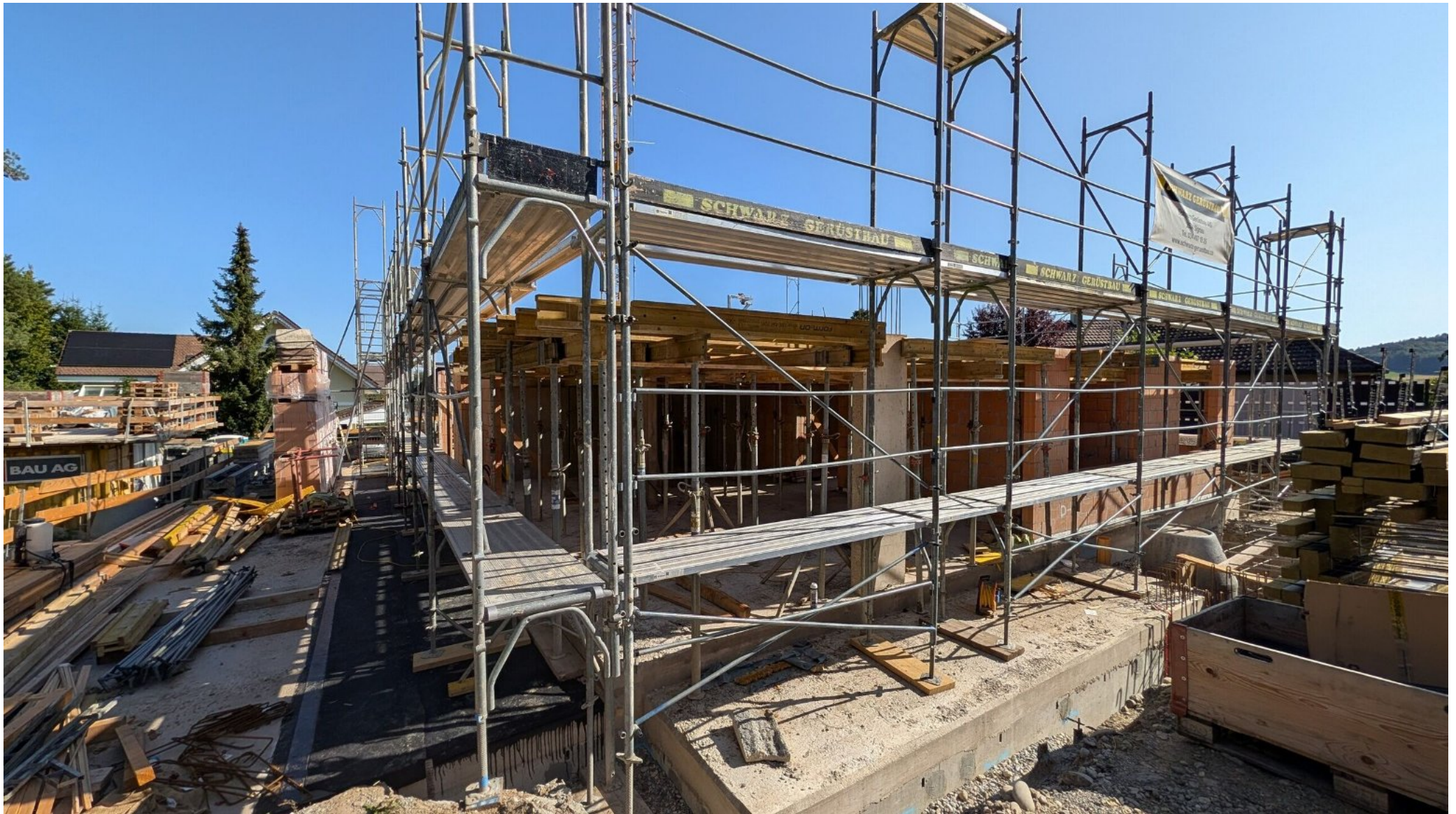
Fassade Süd Whg 1345-1 mit priv. Garten (ganzer Südbereich)
