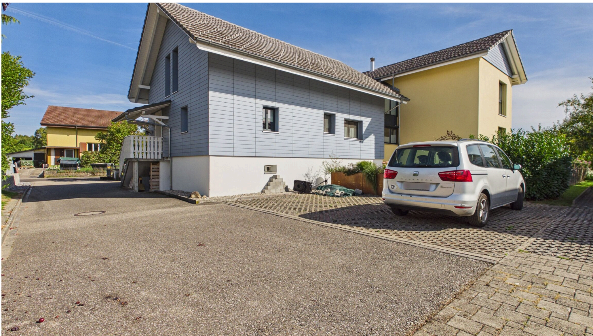
Aussenplatz Nordwest (Hausteil blau und gelb)
