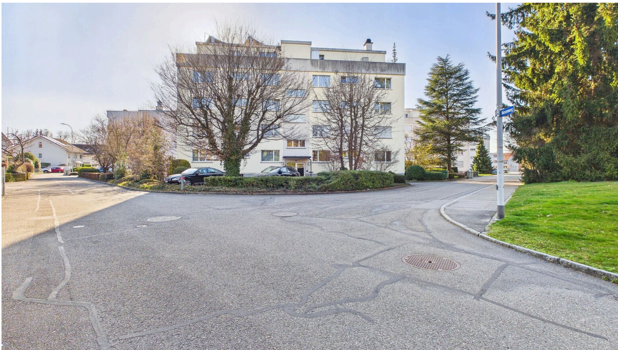
Ansicht MFH Eigerweg 8 (Nordost)
