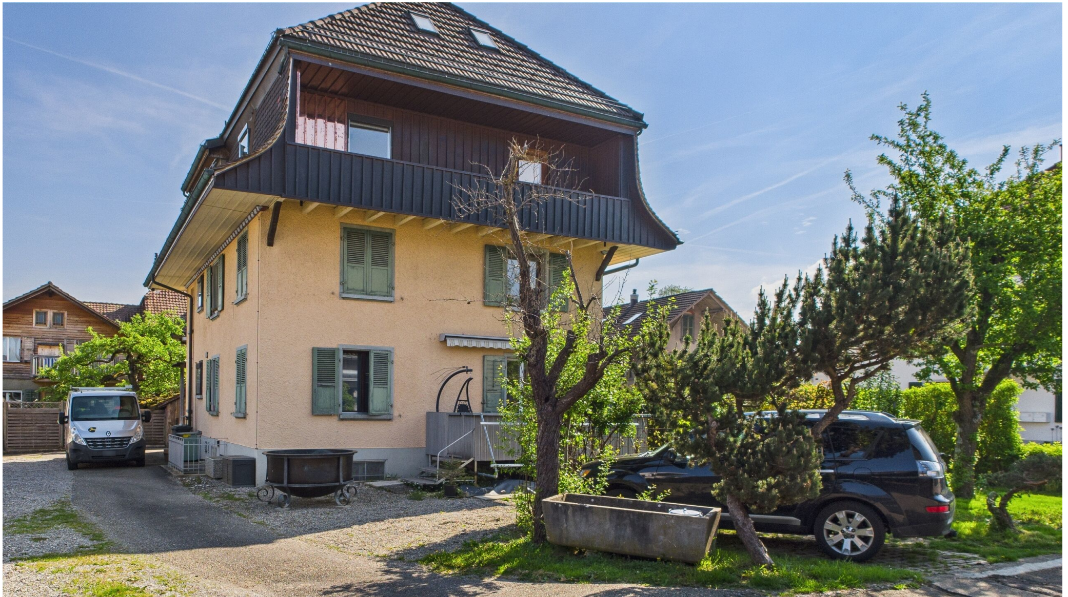
Balkon Hochparterre (Westausrichtung)
