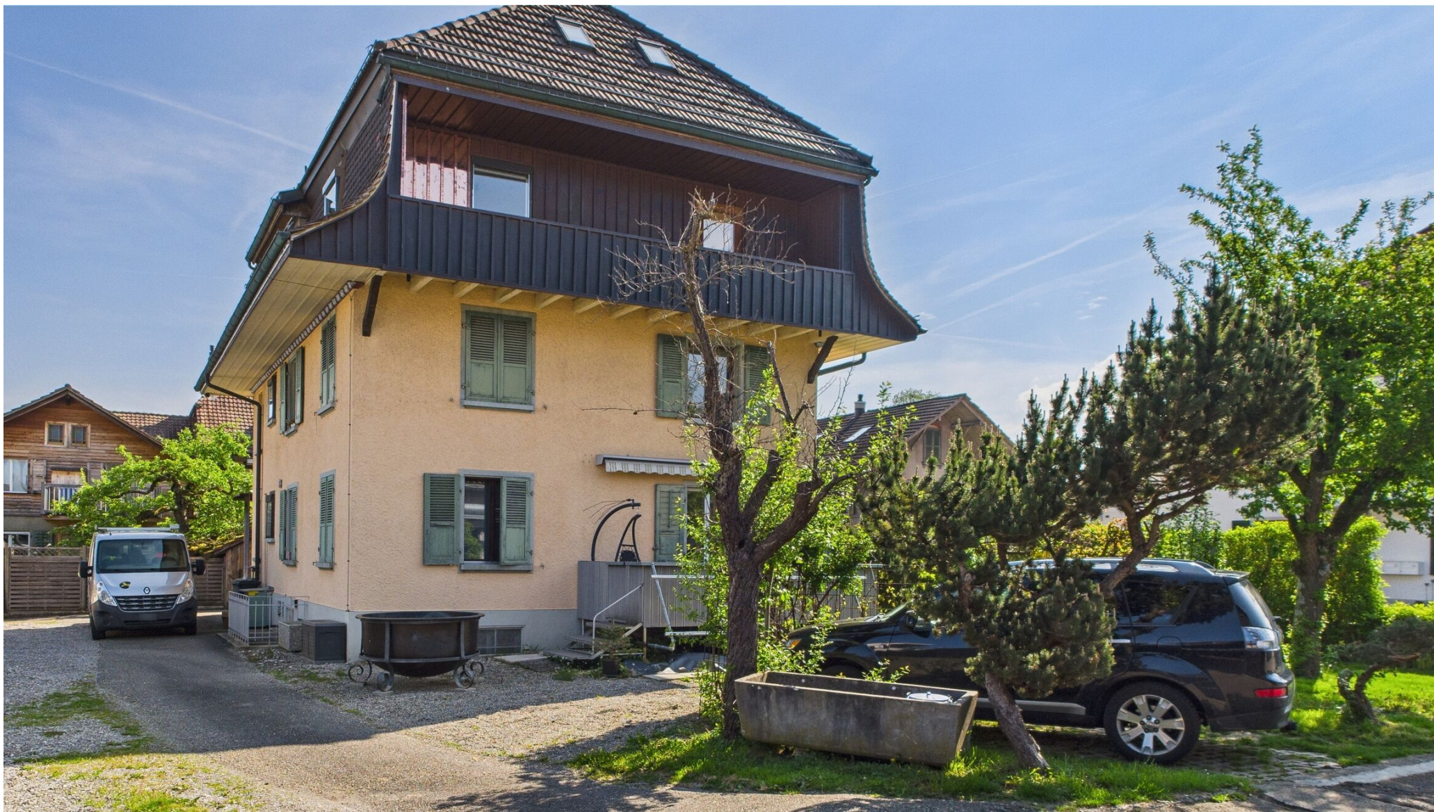
Balkon Hochparterre (Westausrichtung)
