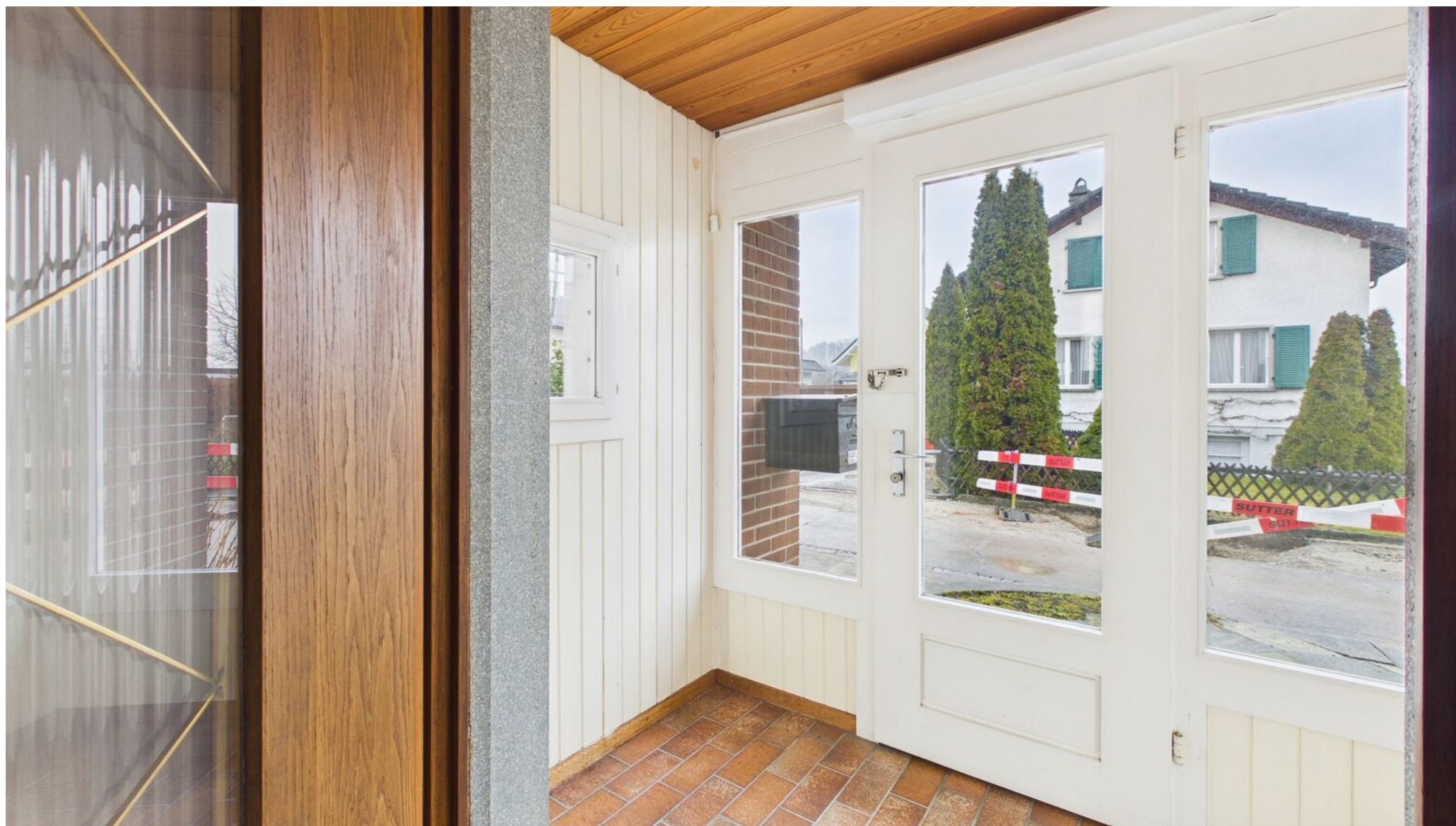
Windfang/Eingang Haus Amselweg 1 (Parzelle 190)
