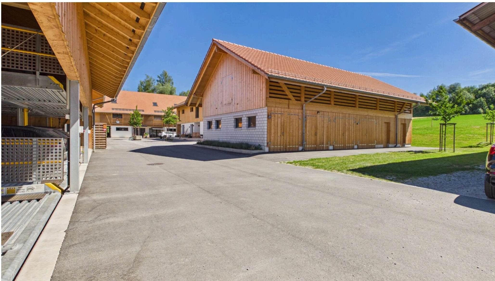
Gebäude rechts mit Allgemeinraum OG und priv. Schopf
