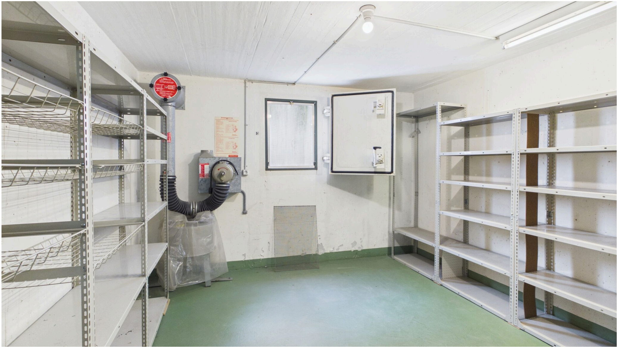
Keller (Schutzraum) UG
