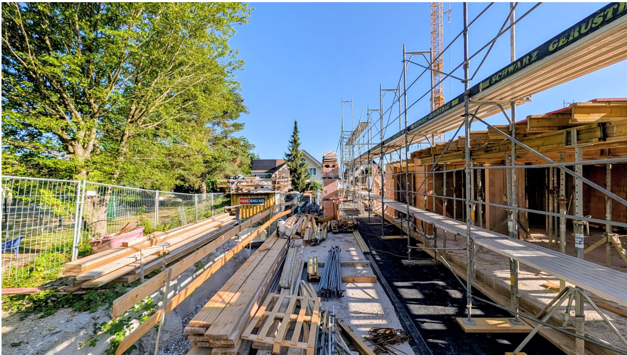
Gartenbereich der beiden EG/OG Wohnungen
