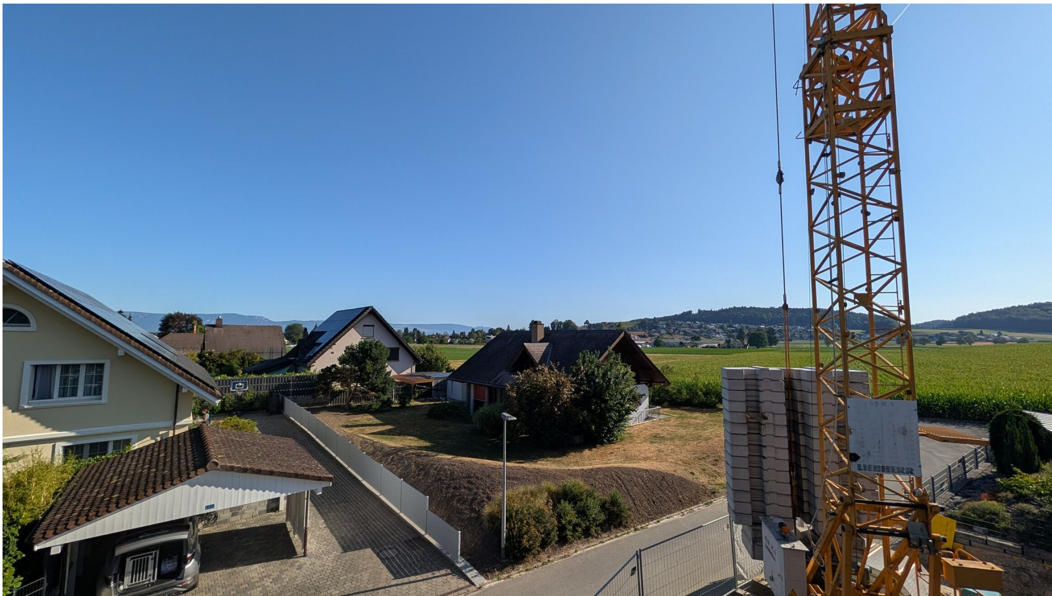
Ausblick Terrasse OG
