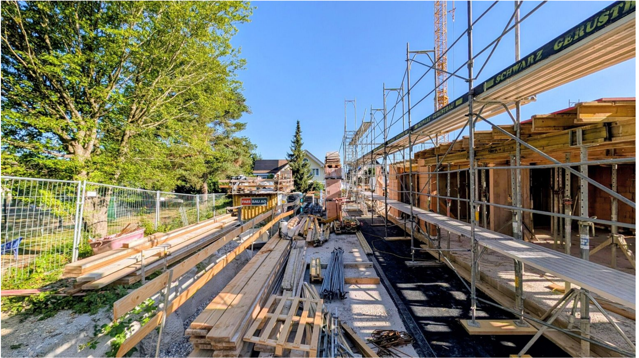
Gartenbereich der beiden EG/OG Wohnungen
