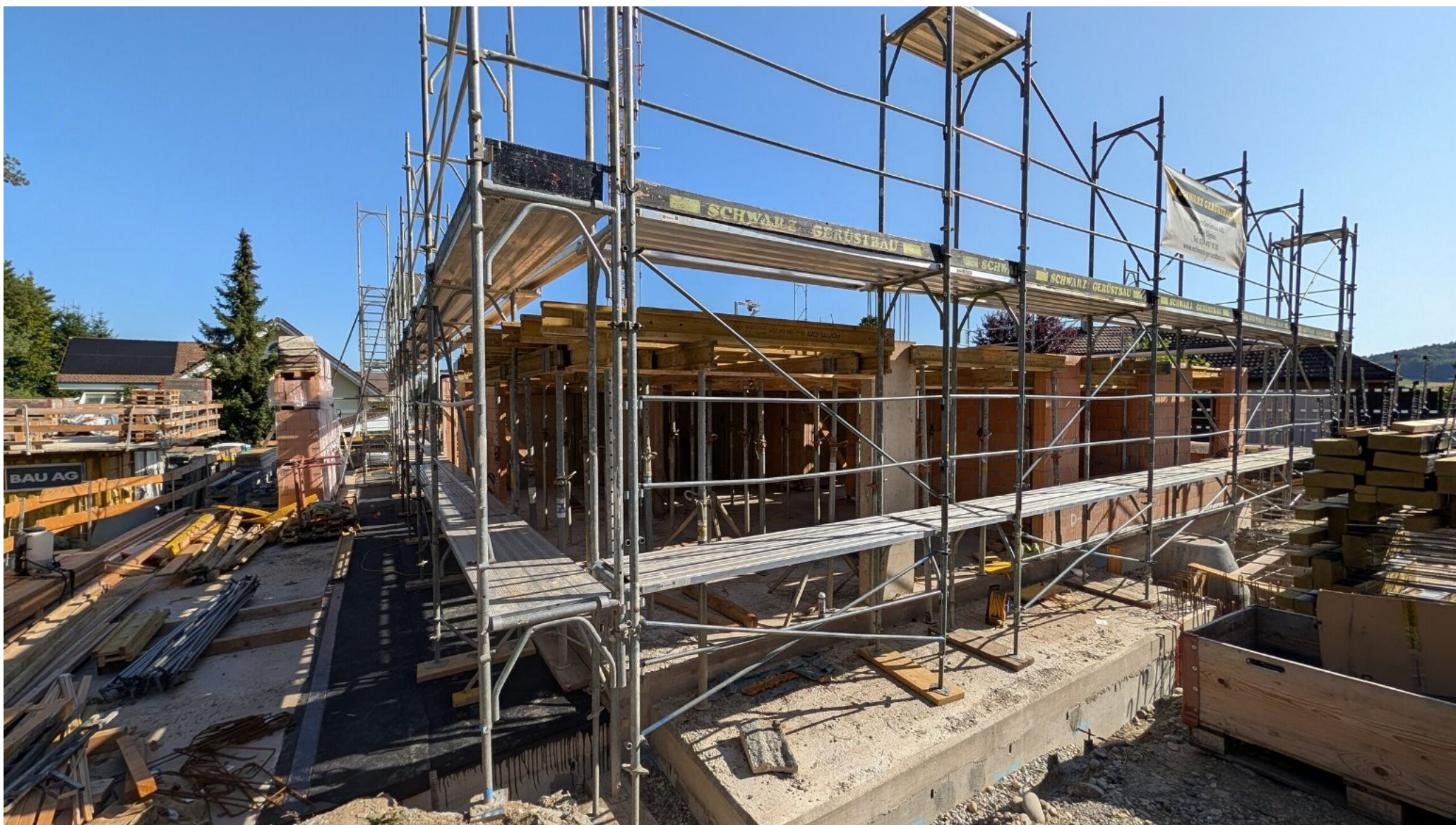
Fassade Süd Whg 1345-1 mit priv. Garten (ganzer Südbereich)
