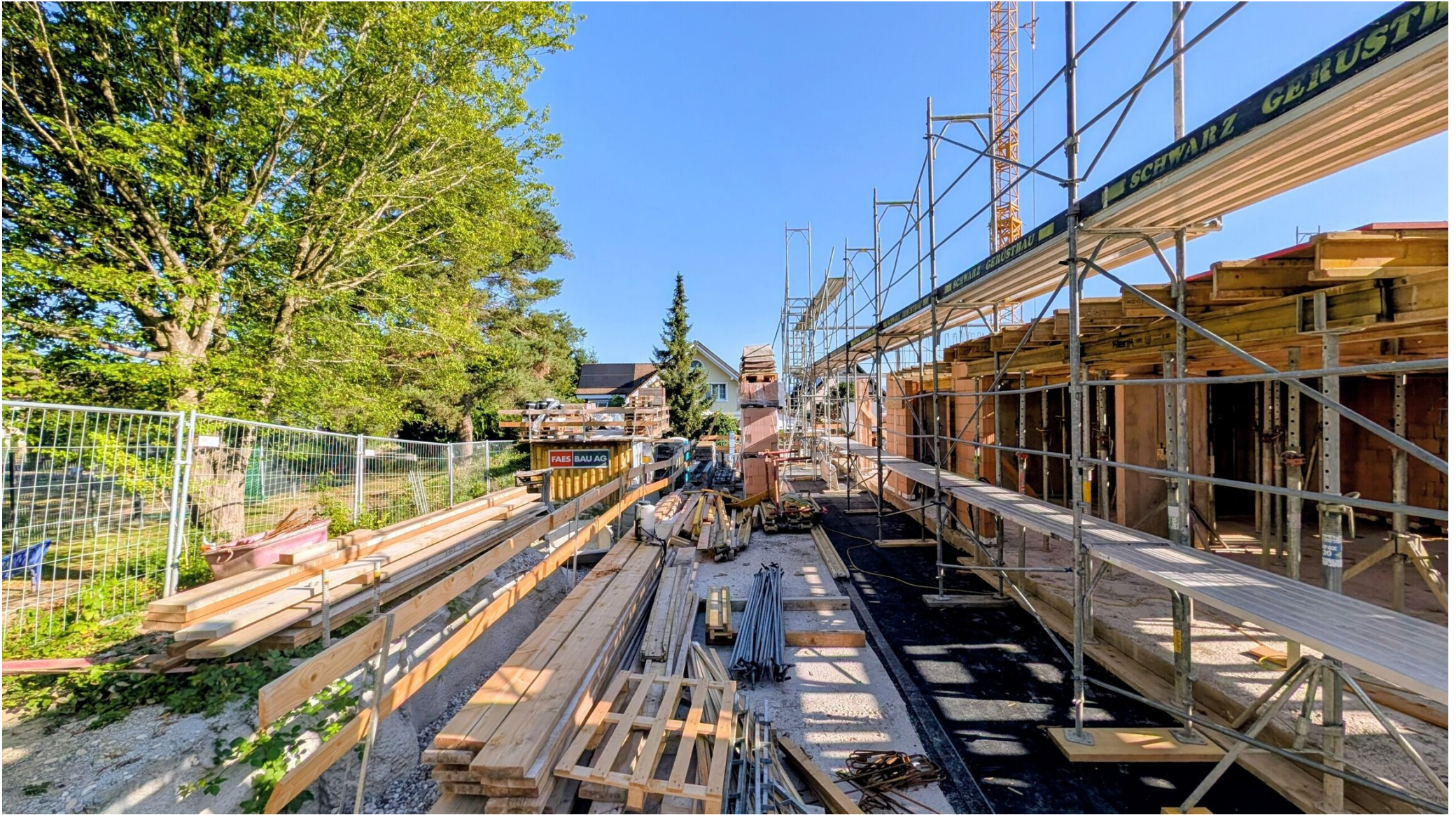
Gartenbereich der beiden EG/OG Wohnungen
