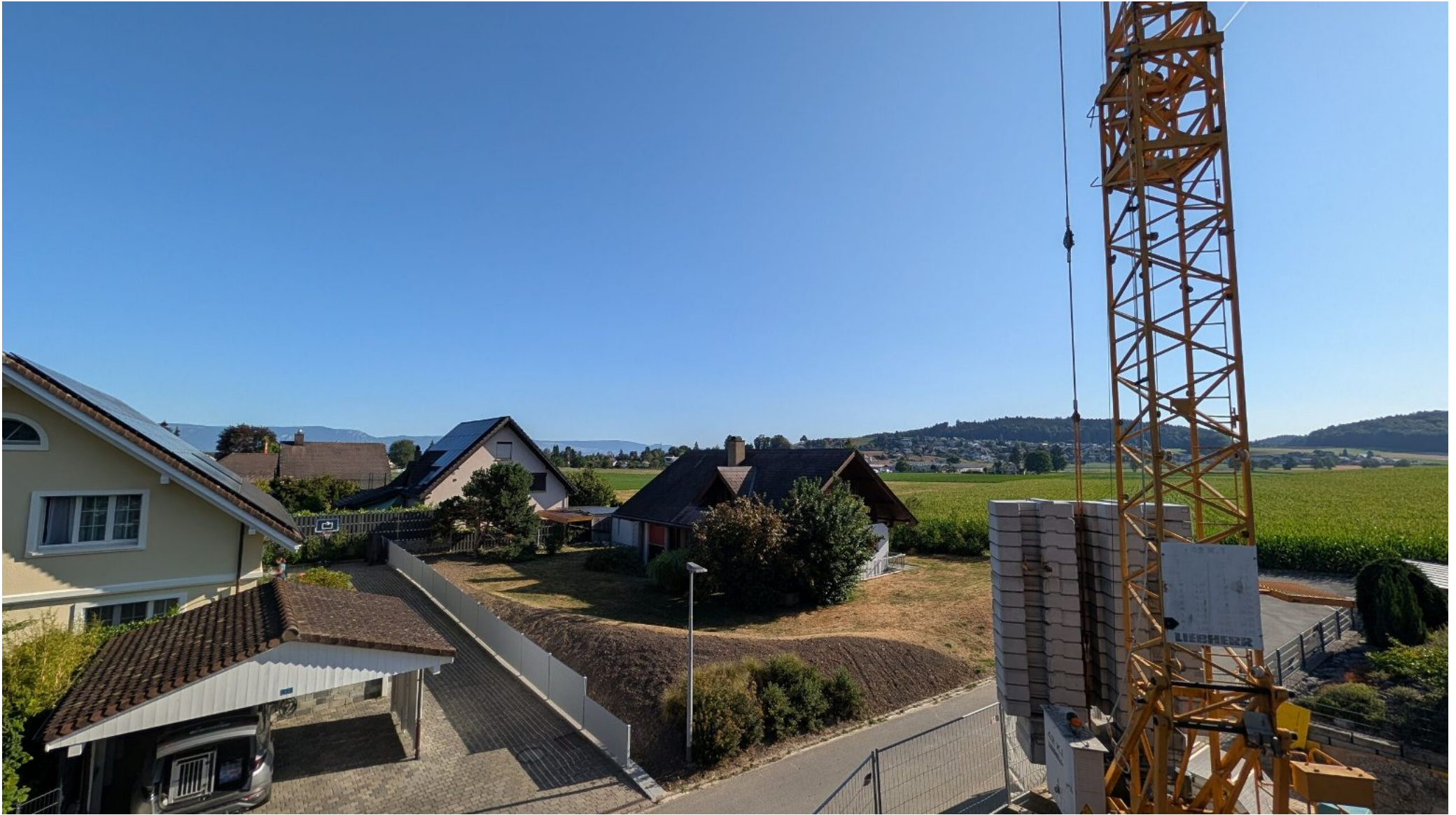
Ausblick Terrasse OG
