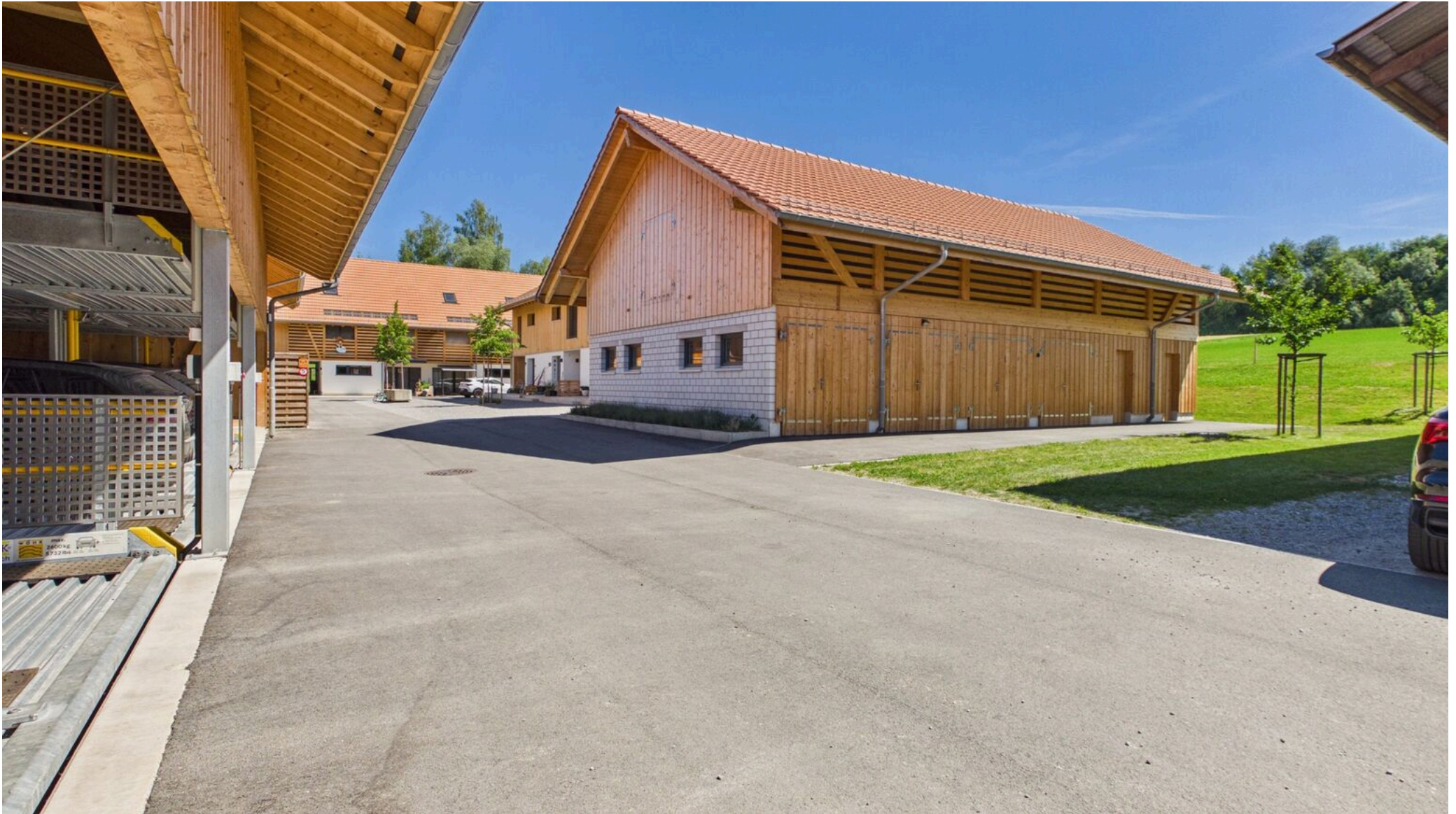
Gebäude rechts mit Allgemeinraum OG und priv. Schopf
