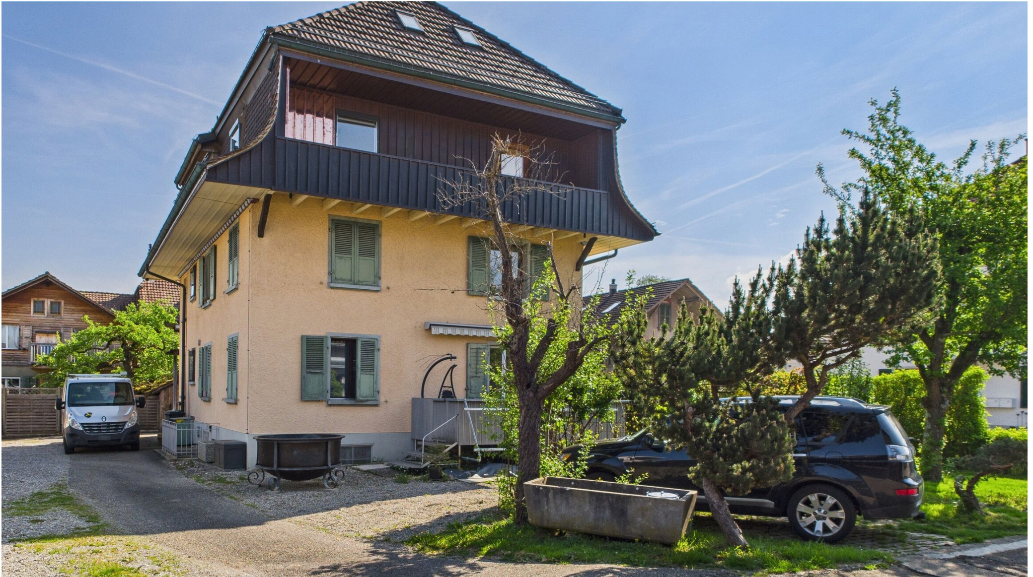
Balkon Hochparterre (Westausrichtung)
