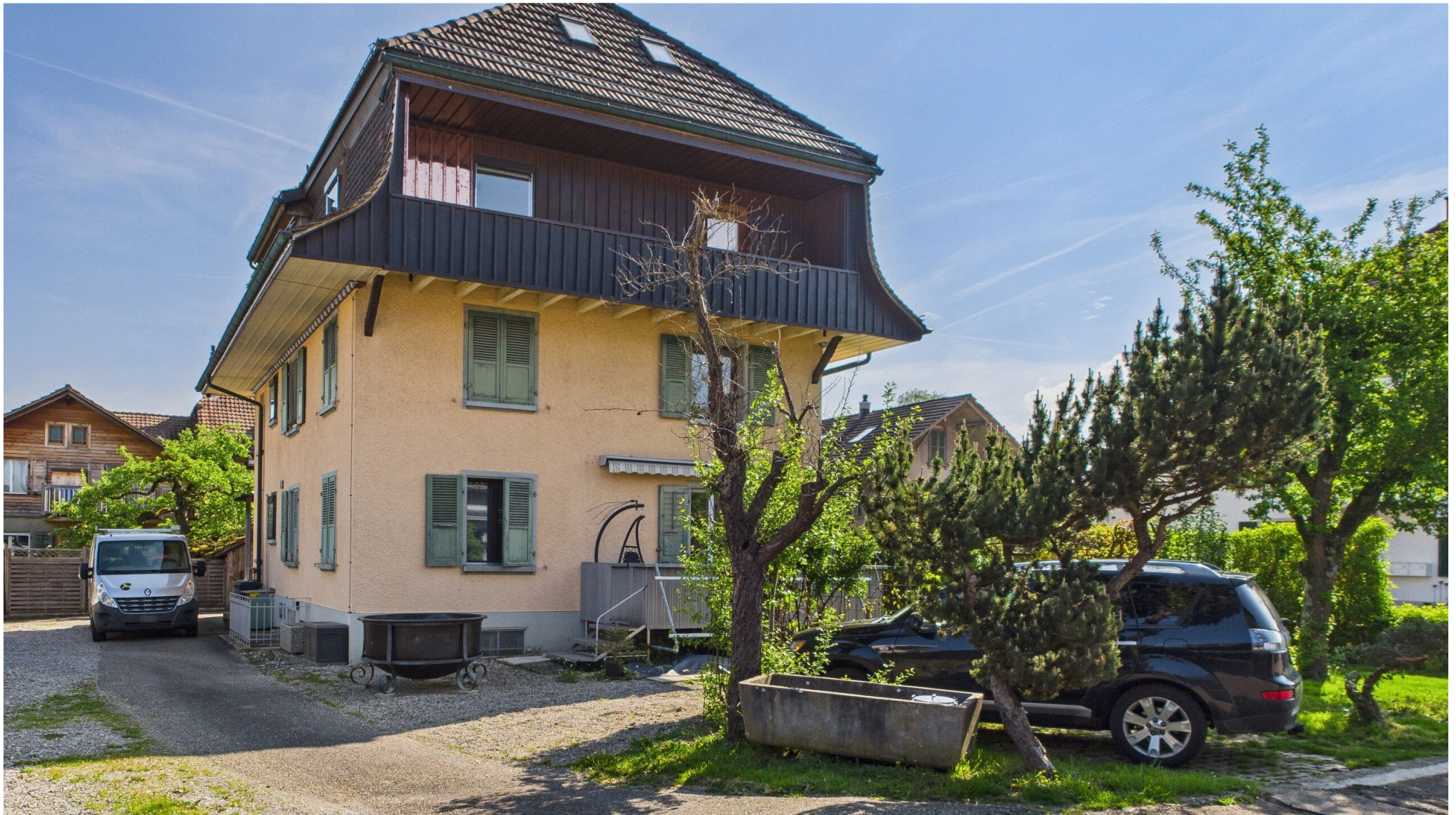
Balkon Hochparterre (Westausrichtung)
