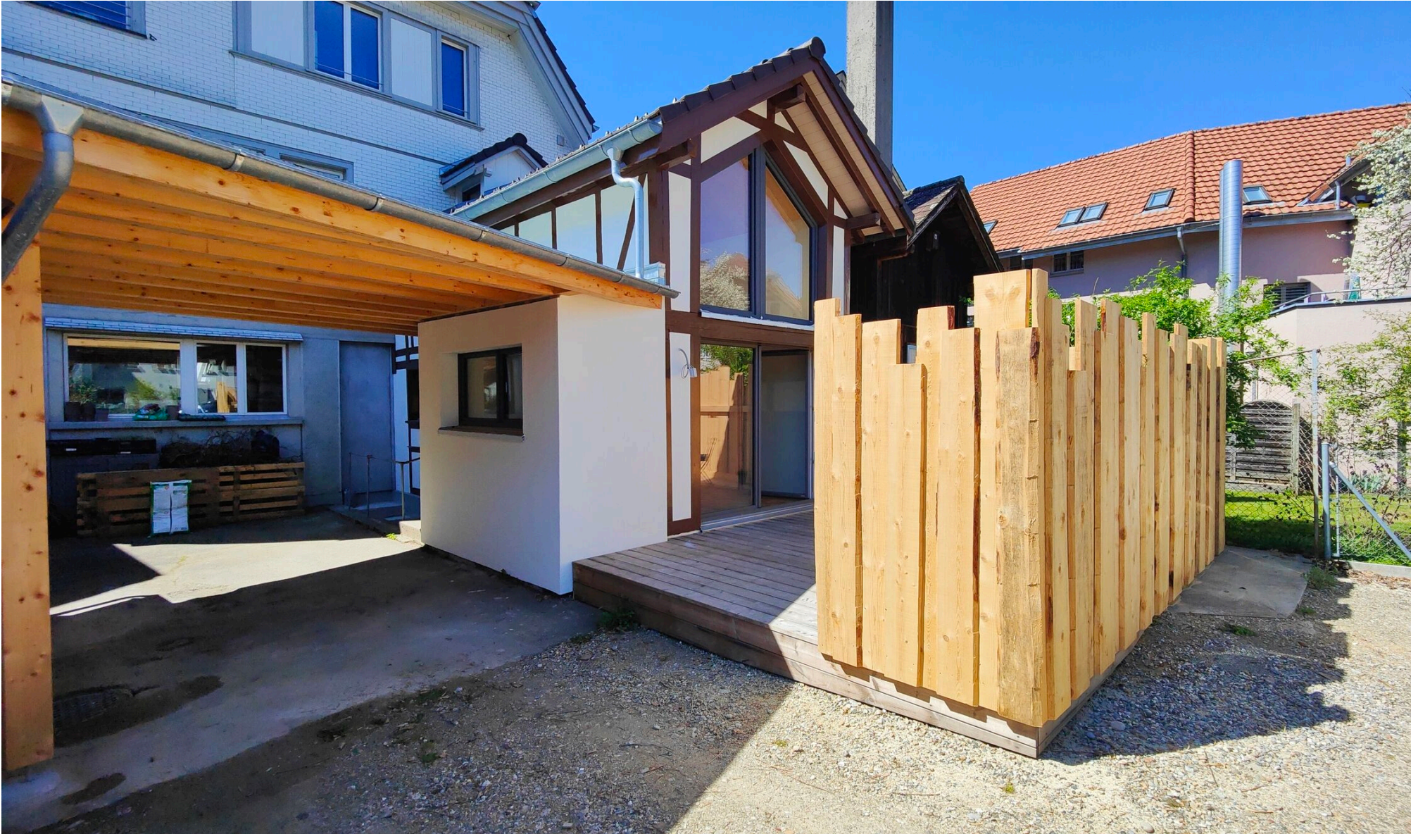
Carport links, rechts Terrasse
