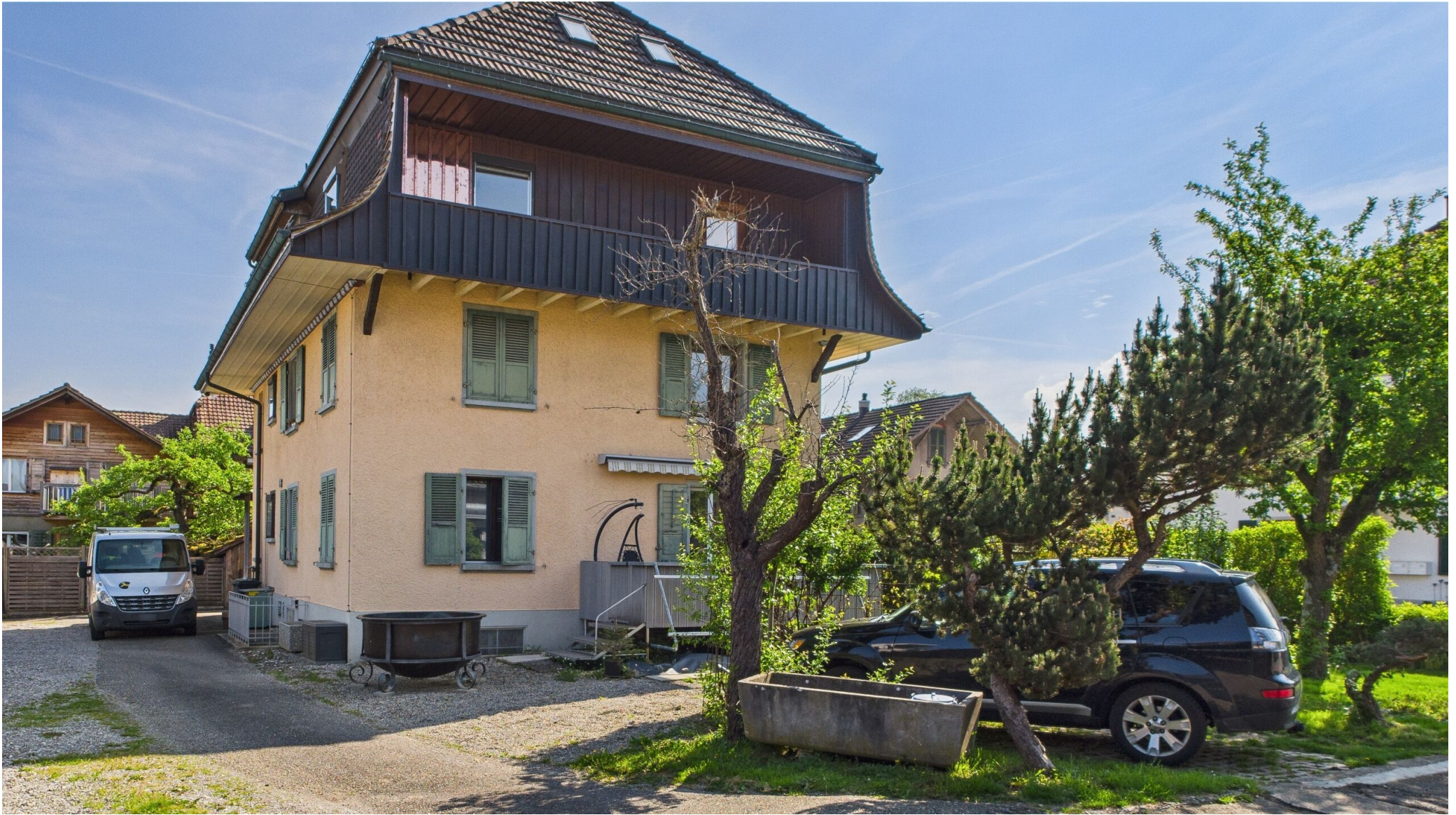
Balkon Hochparterre (Westausrichtung)
