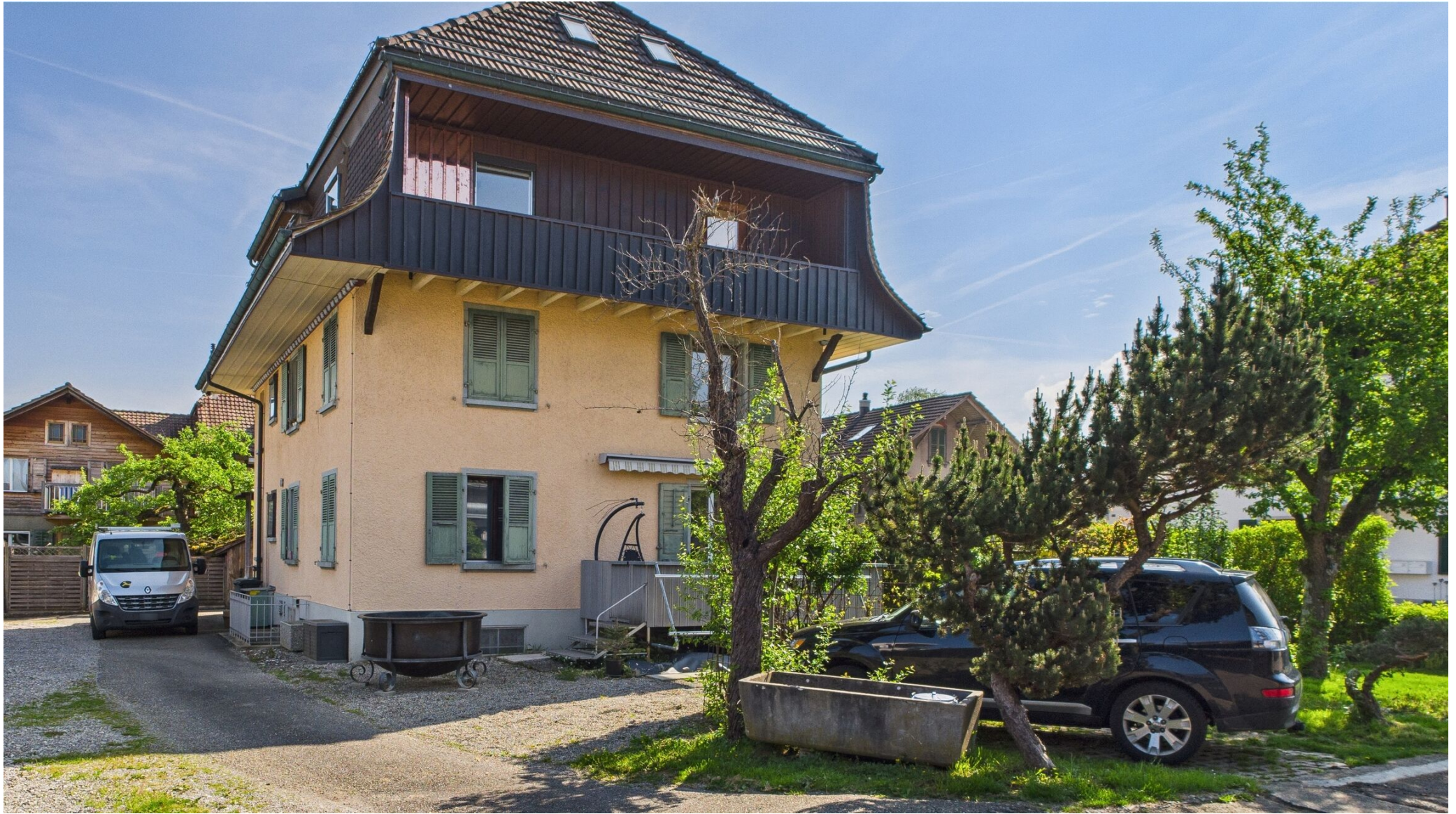
Balkon Hochparterre (Westausrichtung)
