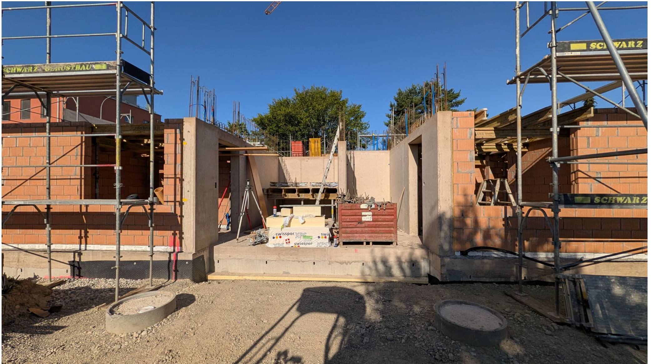
Eingangsbereich (Ost) mit Treppe und Lift
