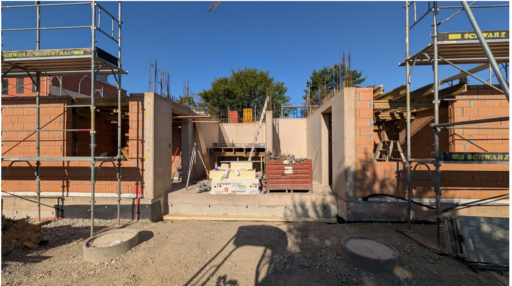
Eingangsbereich (Ost) mit Treppe und Lift
