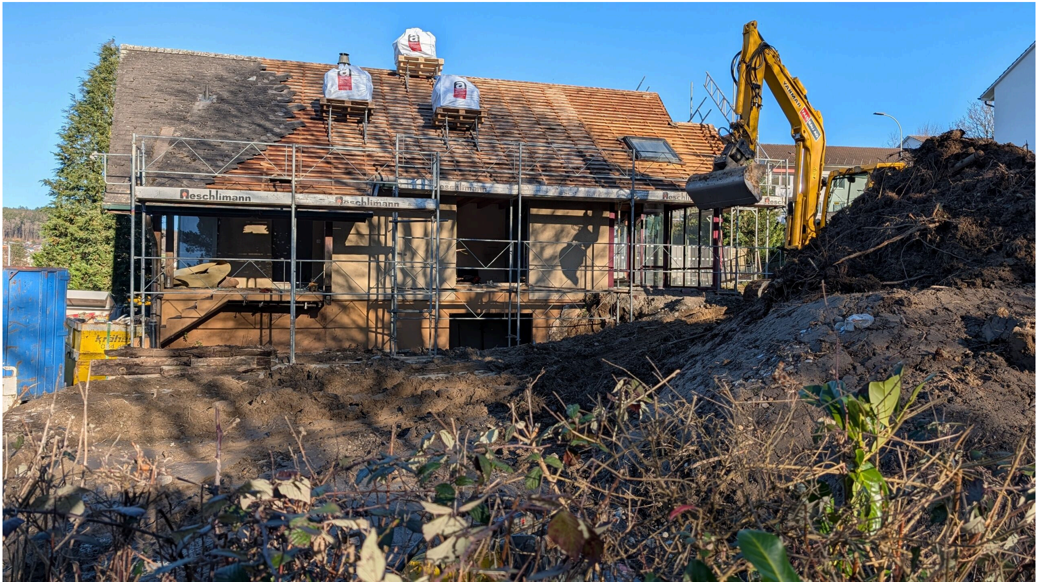
Das EFH wird abgerissen
