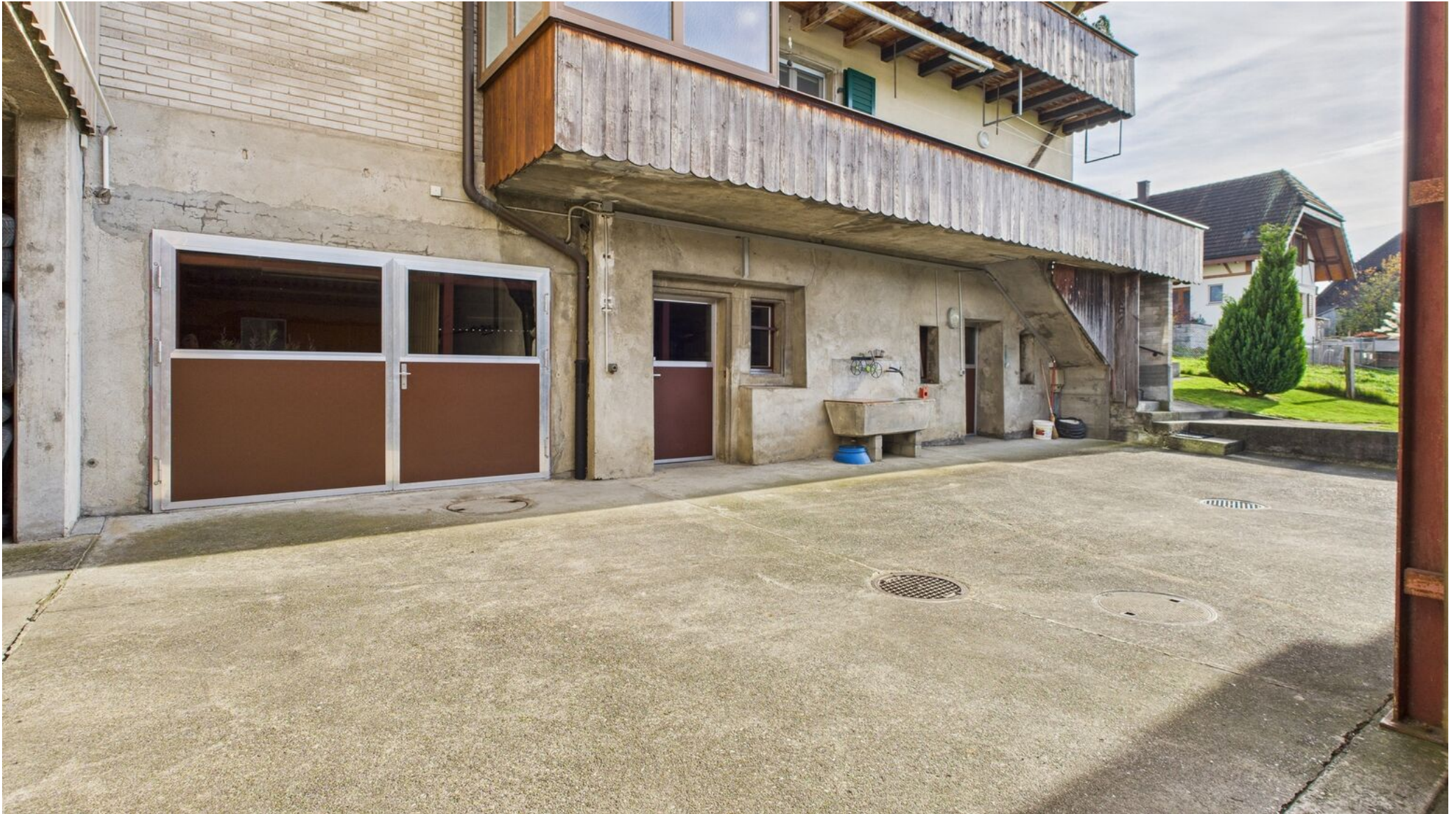
Vorplatz mit Zugang Gewölbekeller/Technik/Garage
