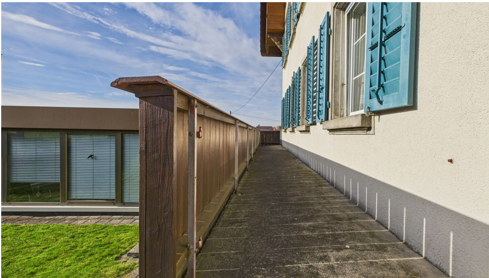
Balkon EG Wohnung
