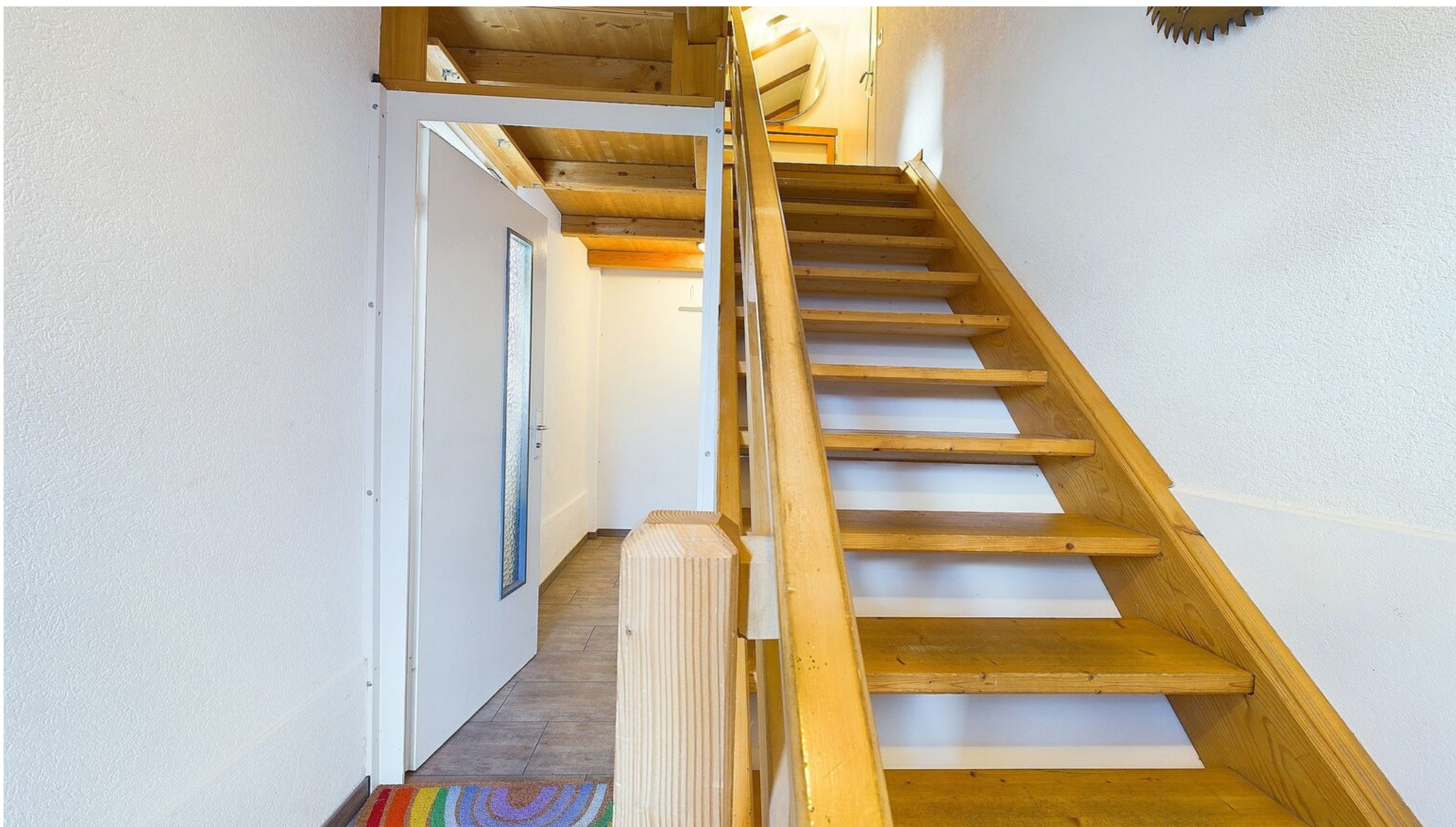
Treppenhaus; Eingang Whg 1
