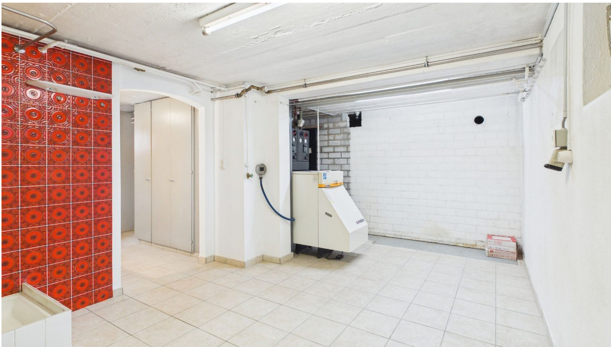
Keller mit Dusche / Heizung UG
