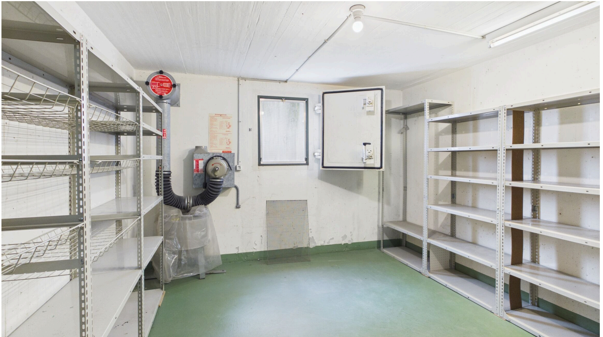
Keller (Schutzraum) UG
