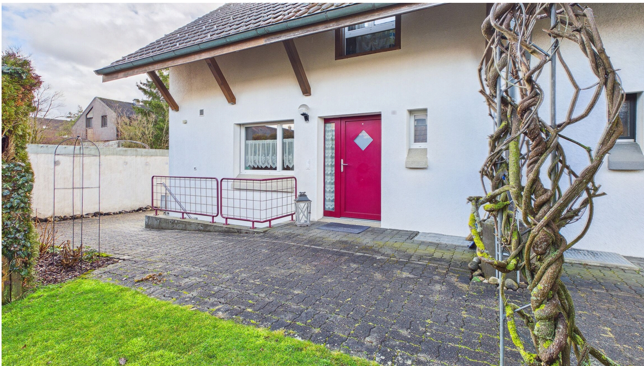
Zugang/Eingang EG sowie Aussentreppe ins UG
