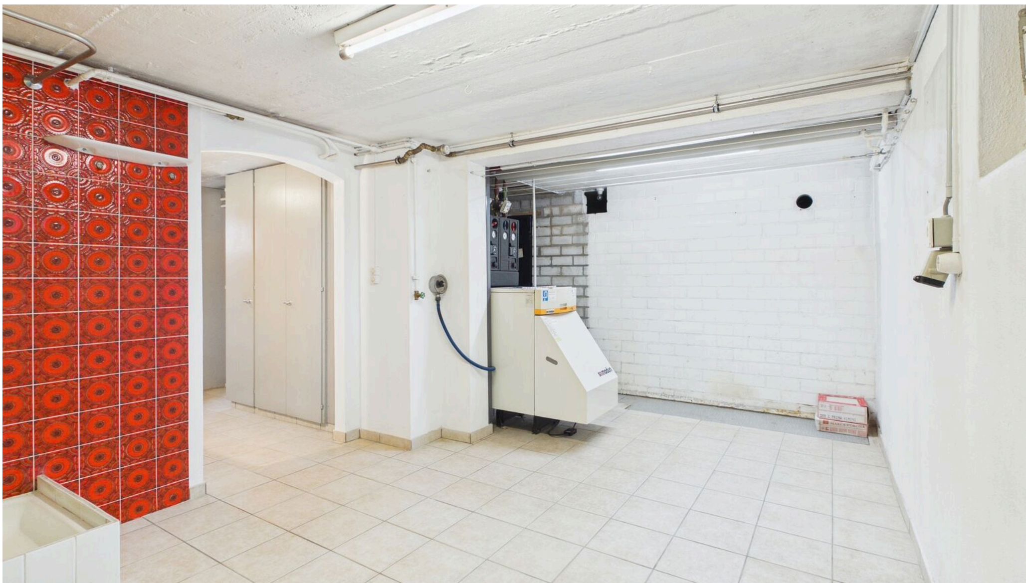
Keller mit Dusche / Heizung UG
